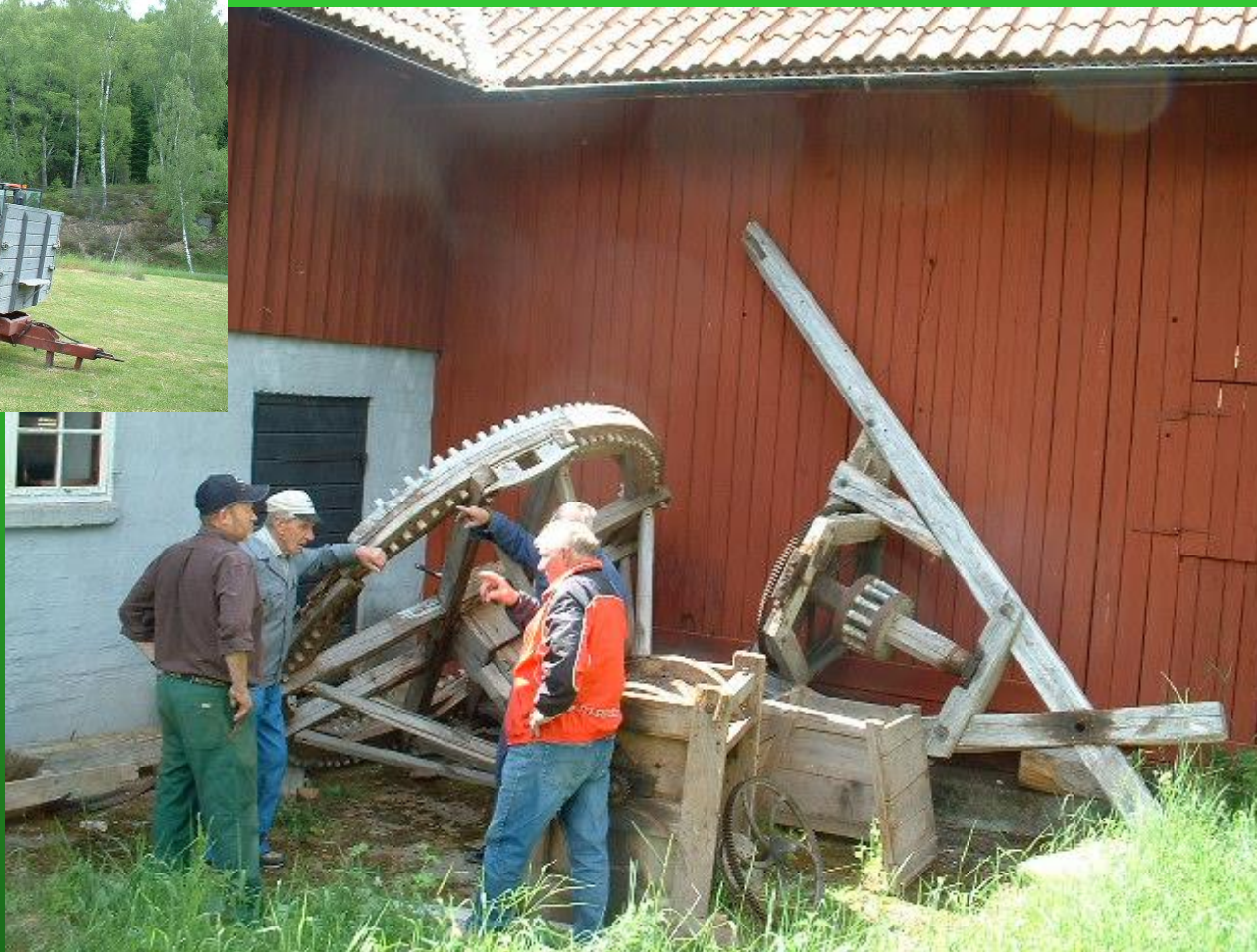
Vandringen är delvis skadad och kloka män diskuterar reparationsmetoder
