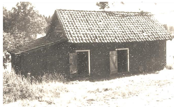
Starkås Ladugården. Byggnadsinventering 1988.
