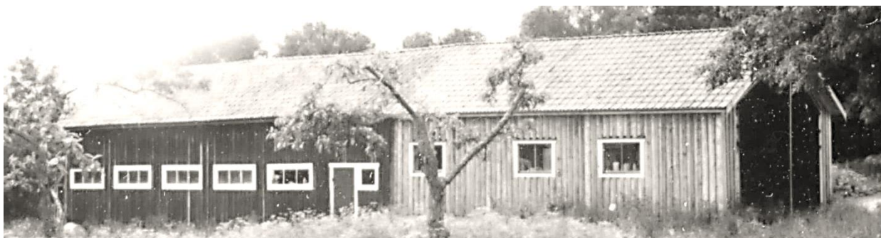
Tillbyggnad av svinhuset. Byggnadsinventering 1988.
