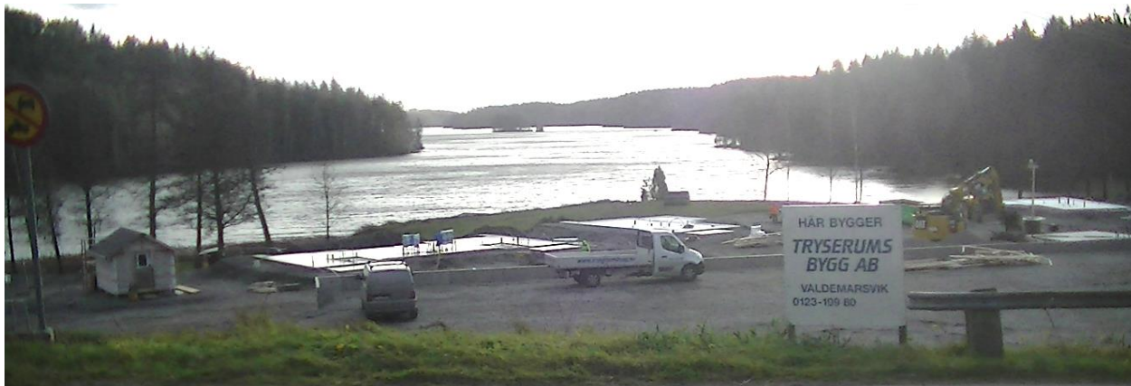
Byggnationen av Kvarnviks Strand drog igång under hösten 2020.
