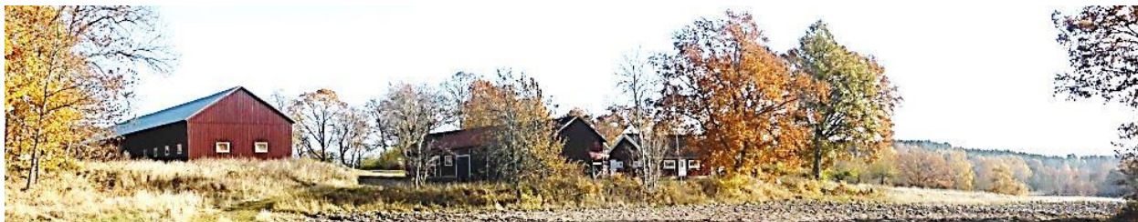
Ekonomibyggnaderna uppfördes 1865. Ekonomibyggnader 2016.
