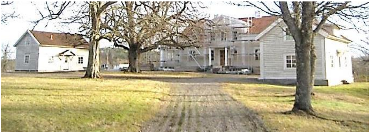
Nora under renovering 2016. Linden i rundeln mellan husen är nedtagen. HBF nr 1684.
