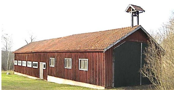
Svinhuset med tillbyggnad 2016. HBF nr 1681.
