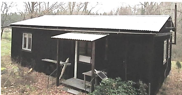
Jaktkojan, som är byggd på den ena ladugårdsgrunden. GE 2015.
