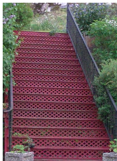
Gjutjärnstrappan i Storsjö.
