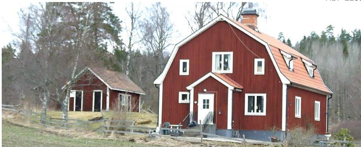
Arrendebostaden. Byggnaden till vänster innehöll två vedbodar, två hönsbodar och två svinstior, en av varje till varje lägenhet. GE 2016.
