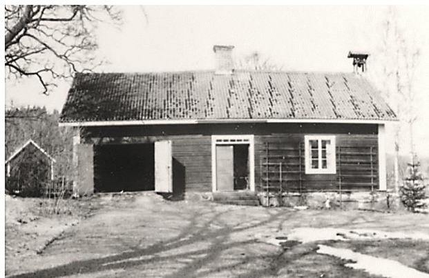
Byggnadsinventering Södra flygeln 1988.
